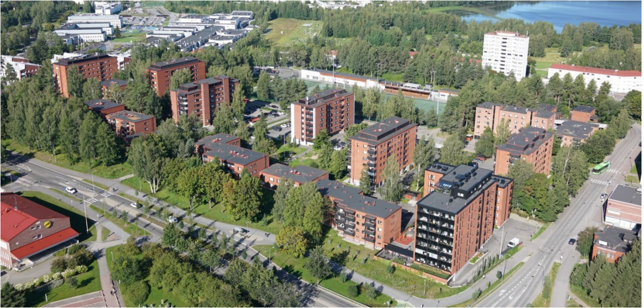
Ilmakuva suunnittelualueen lähiympäristön rakennuskannasta, joka muodostaa kaupunkirakenteellisesti ja -kuvallisesti yhtenäisen punatiilisten rakennusten kokonaisuuden (2023)
