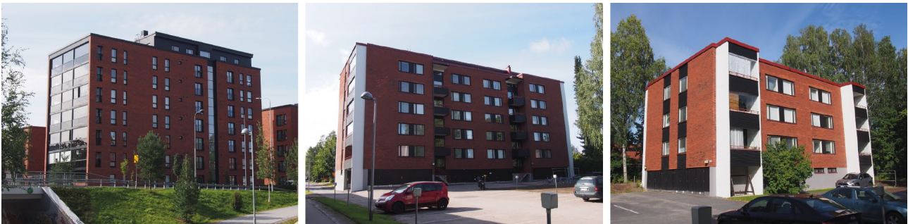
Kuvia suunnittelualueen lähiympäristön rakennuskannasta. Vasemmalla 1/2021 valmistunut Sepänkatu 7a, keskellä 12/1974 valmistunut Sepänkatu 16 kadun varren rakennus ja oikealla 12/1974 valmistunut Sepänkatu 16 sisäpihan rakennus. (7/2023)
